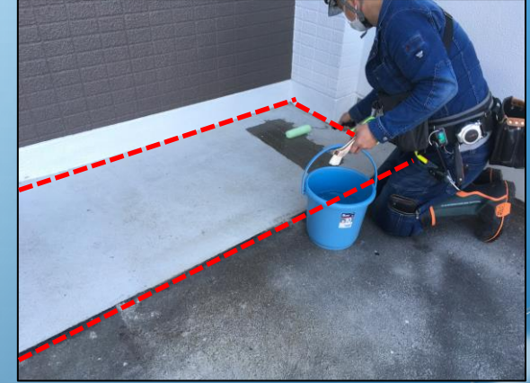
IZW.Shield 塗布状況(翌日)
