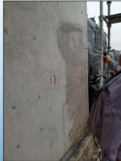
IZW.Guard塗布後の状況
