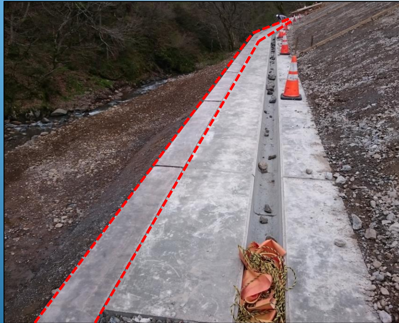
IZW.Guard塗布後の状況
