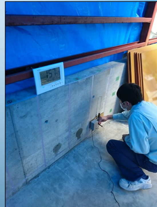
透水量測定状況
