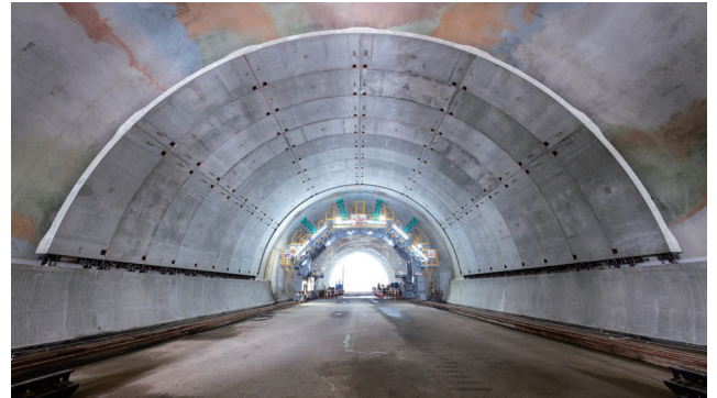
実寸大の模擬トンネルに適用した分割型PCa覆工
