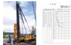
N値が極端に低く、削孔の進捗が早すぎる場合は計測が出来ません
