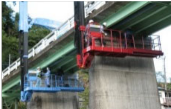
御鉾橋 上部工の損傷状況調査
