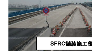
SFRC舗装上のAs舗装施工後
