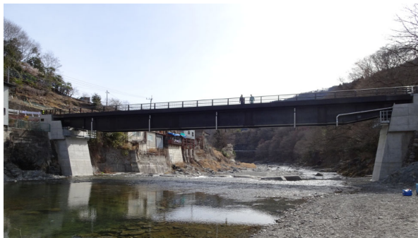
御鉾橋 完成(全景)
