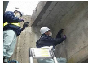
AEセンサを利用したPCクラウド充填把握
