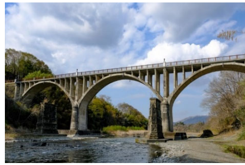
秩父橋 完成(全景)
