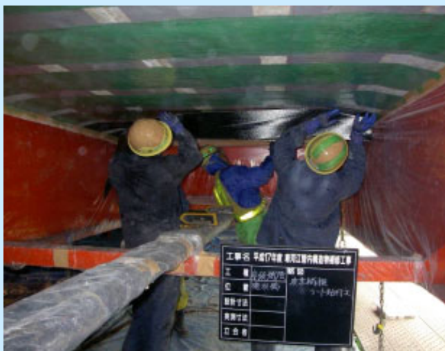
予防保全（補修工事）
