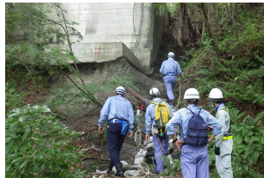
秩父橋 P4橋脚浸食状況調査
