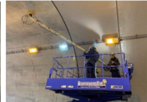
レーダーを利用したトンネル覆工の変状把握
