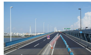
SFRC舗装上のAs舗装施工後
