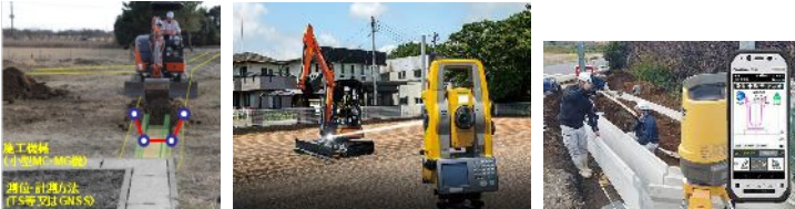
小型施工機械へのICT導入、小規模な現場での3次元設計データ利活用を検証
