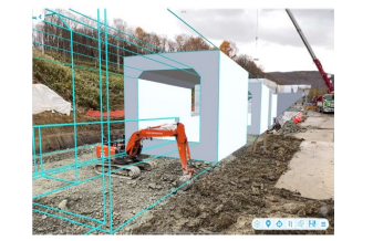
掘削作業時にARと比較
