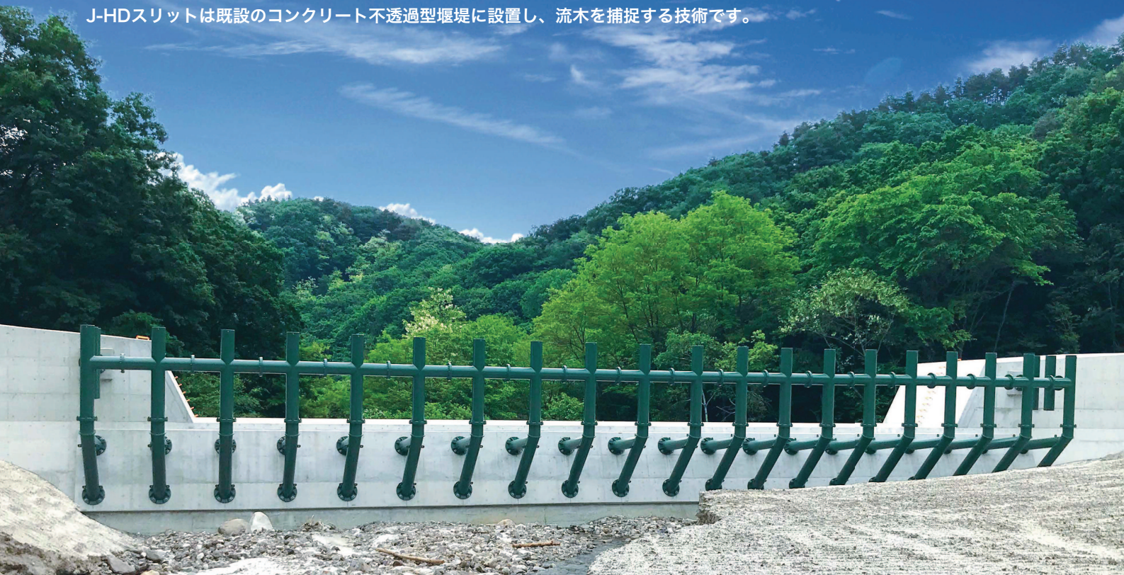
既設コンクリート堰堤に
