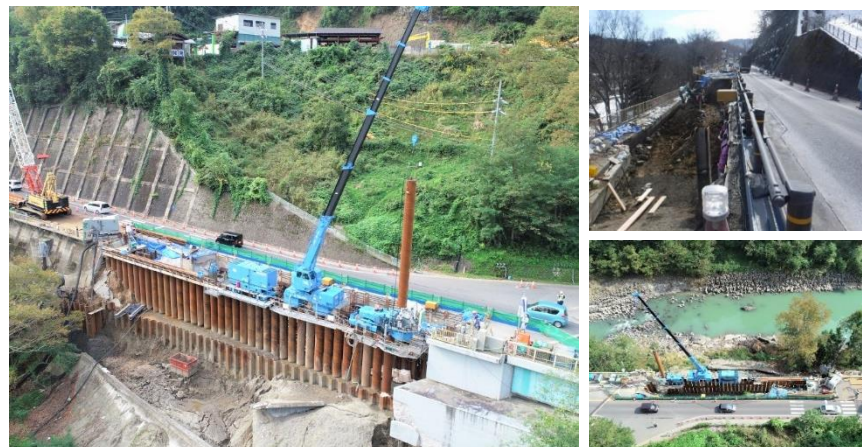
災害復旧工事（法面復旧）
