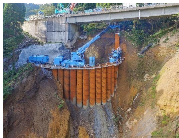
災害復旧工事（橋台基礎復旧）
