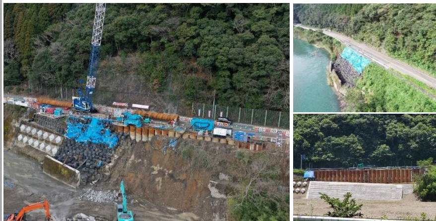
災害復旧工事（法面復旧）
