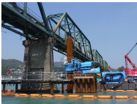
橋脚基礎補強工事
