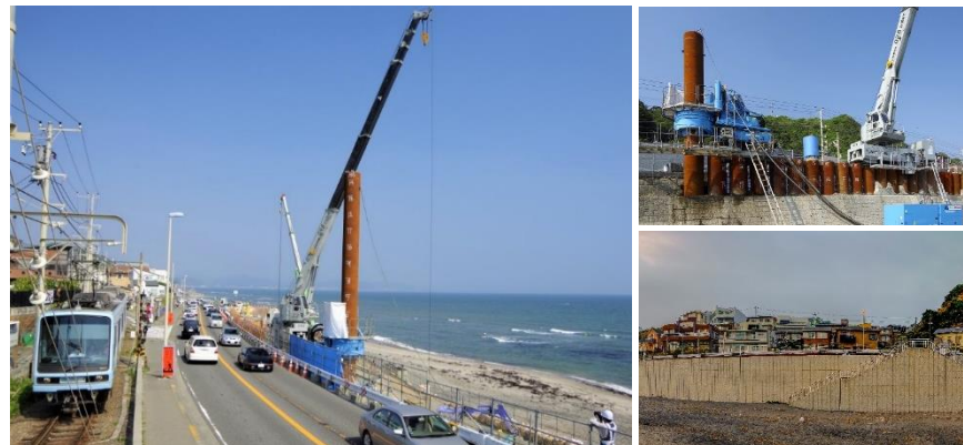
災害復旧工事(海岸_擁壁復旧)
