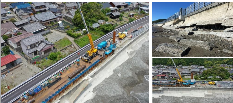
災害復旧工事(海岸_擁壁復旧)
