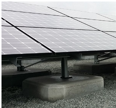
山口県 太陽光発電パネルの基礎
