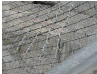
切断したネットを補修
