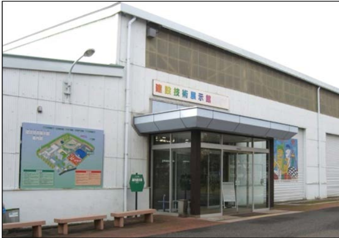
建設技術展示館
