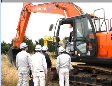
ICT建機施工体験
