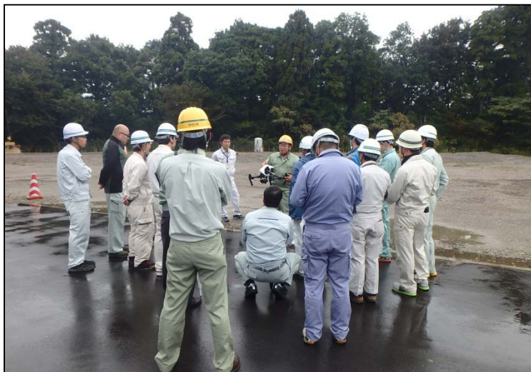
UAVを用いた起工測量の実演 ((株)西尾レントオール)
