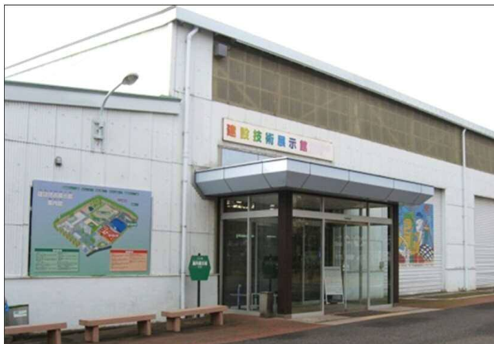
建設技術展示館
